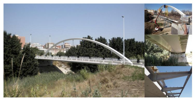
El puente sobre el Barranco de Picassent es un arco de tablero superior. Su único vano tiene una luz de 51,50 m y su tablero una anchura de 14 m. Está compuesto por un arco metálico y un tablero mixto conectado al arco mediante péndolas de acero.
